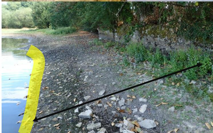
*Une tranchée d'ancrage (bande jaune) avec de l'argile sera réalisée au pied de la digue afin de garantir l'étanchéité de l'étang. De l'argile et de la pierre seront également étalées depuis la tranchée d'ancrage et jusqu'à la partie plus haute de la digue pour renforcer l'étanchéité et combler les galeries de ragondins (trait noir).*
