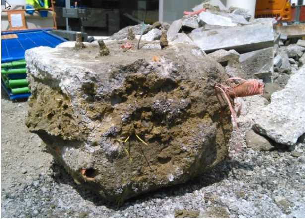
Réseau pris dans le béton
