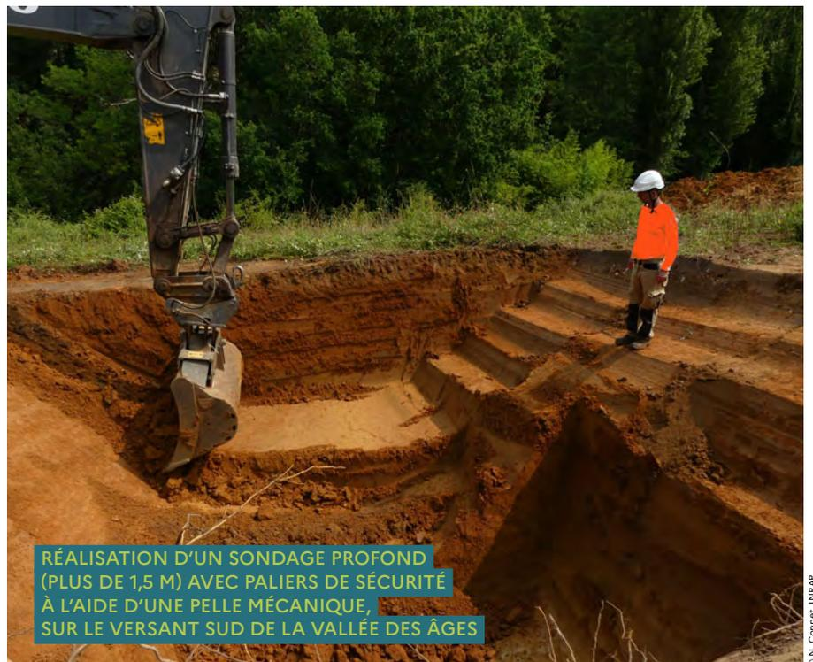
RÉALISATION D'UN SONDAGE PROFOND (PLUS DE 1,5 M) AVEC PALIERS DE SÉCURITÉ À L'AIDE D'UNE PELLE MÉCANIQUE, SUR LE VERSANT SUD DE LA VALLÉE DES ÂGES
