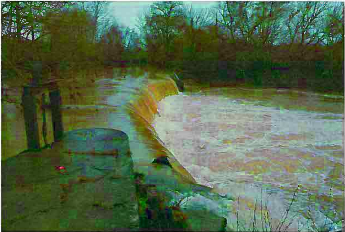
Figure 3 - Vue du barrage depuis le moulin, en rive droite (06/07/2017)
