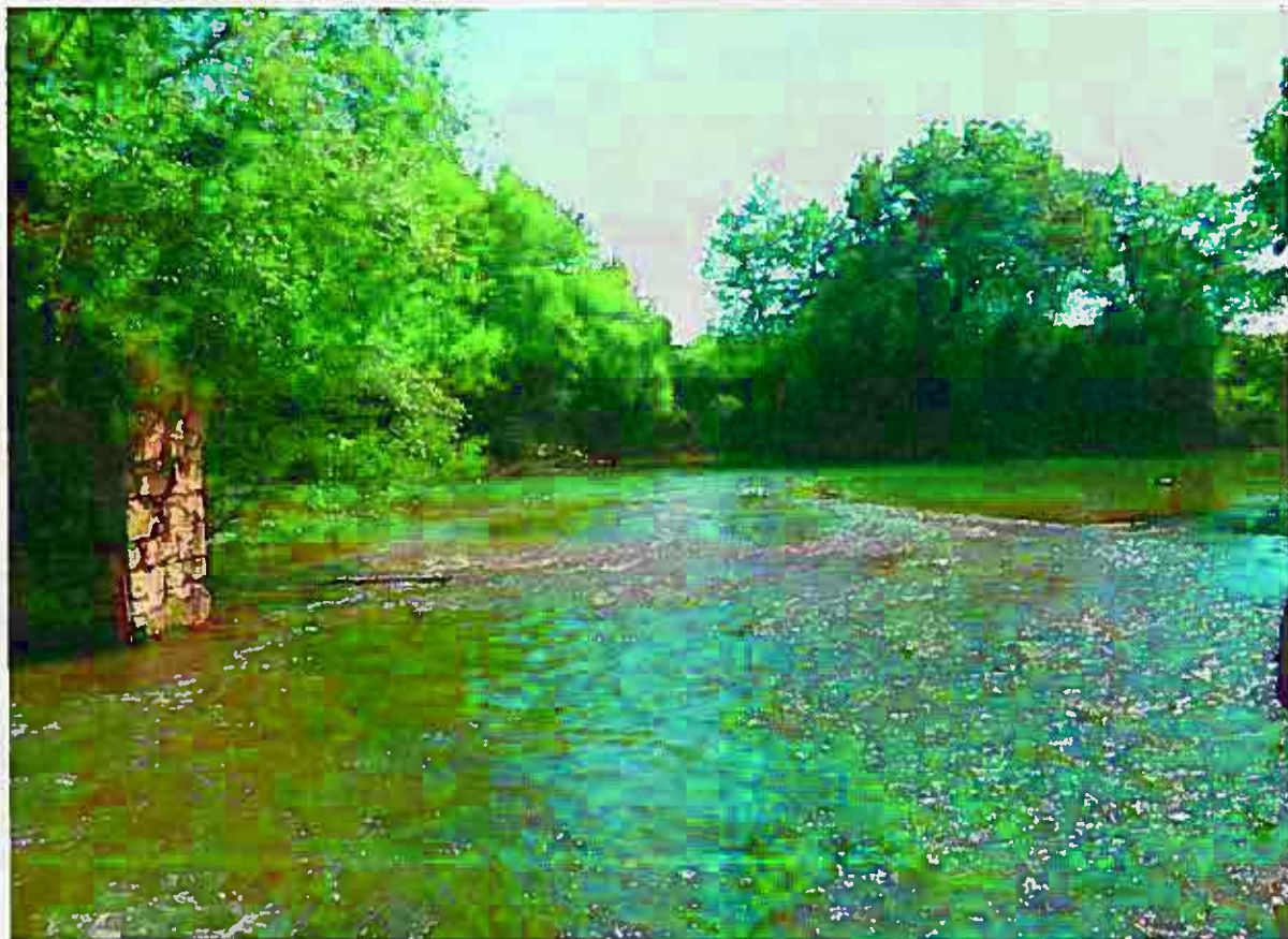
Figure 8 - Vue de la confluence entre le canal de sortie et la rivière, depuis la rive gauche (26/06/2018)
