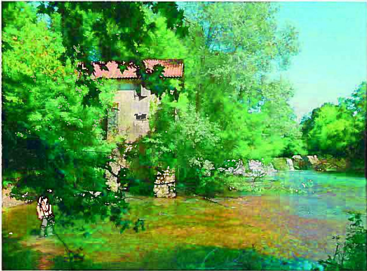
Figure 7 - Vue du moulin, du canal de sortie et du barrage depuis l'aval (26/06/2018)
