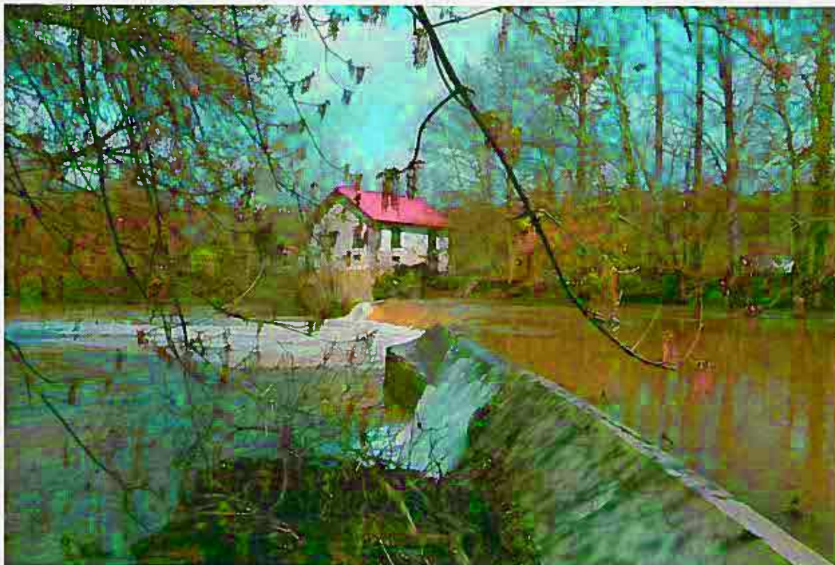
Figure 1 - Vue du barrage et du moulin depuis la rive gauche (06/07/2017)
