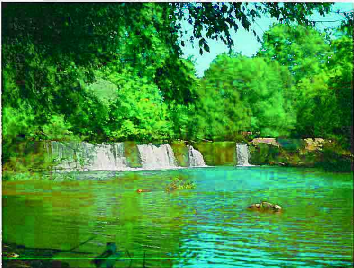
Figure 4 - Vue du barrage depuis l'aval (26/06/2018)
