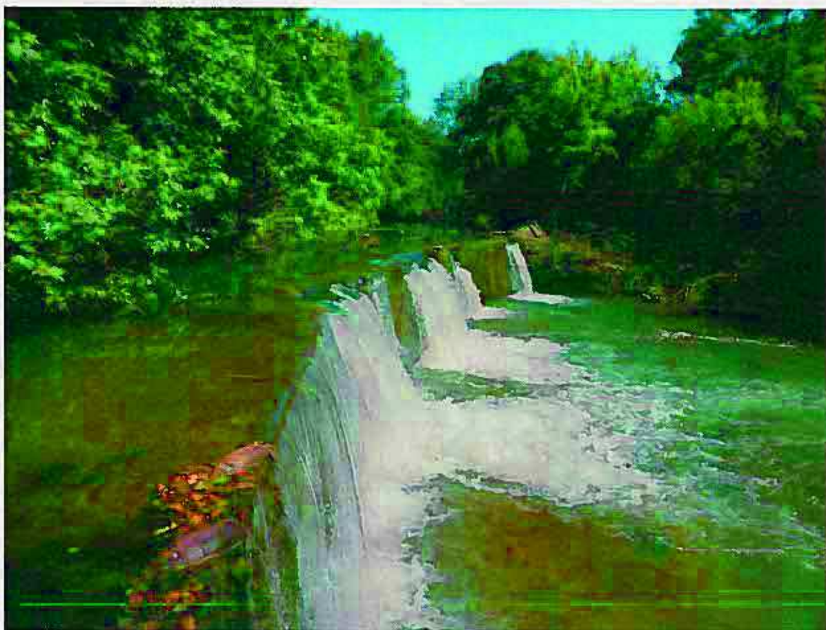
Figure 2 - Vue du barrage depuis le moulin, en rive droite (26/06/2018)
