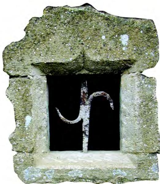
**Figure 36. Fenêtre avec linteau monolithe à accolade appareillée en « *grison* » (XV<sup>e</sup>-XVI<sup>e</sup> s.).**
