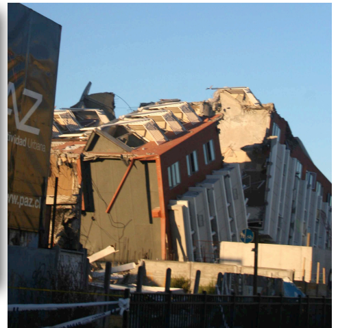
Exemple d'une construction en béton armé endommagée lors du tremblement du Chili (2010). Même en béton armé, un mauvais respect des règles de conception entraîne la destruction complète de la structure.
