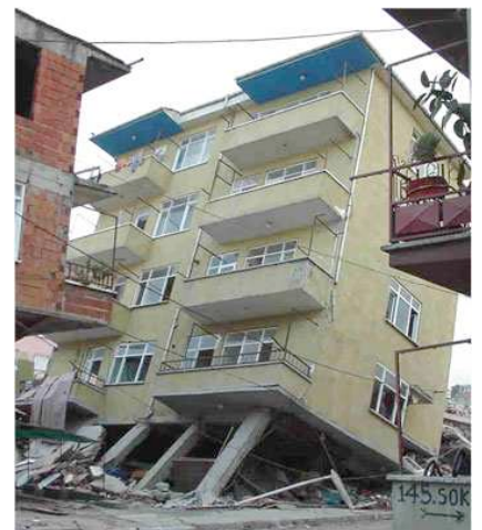
Exemple de dommage dû à l'irrégularité en élévation. Etage transparent ou souple.
