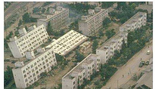
Exemple de dommage dû à l'environnement. Tassement de la structure dû à la liquéfaction
