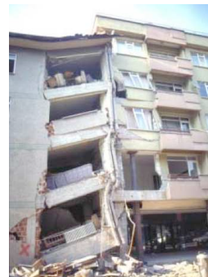
Exemple de dommage dû à l'environnement. chocs entre deux bâtiments adjacents.
