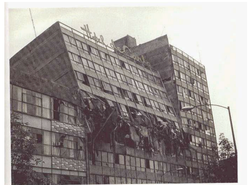
Exemple de dommage dû à l'irrégularité en élévation. Variation des géométries.
