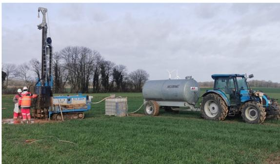
Réalisation en mars 2023 des sondages géotechniques complémentaires pour les ouvrages d'art
