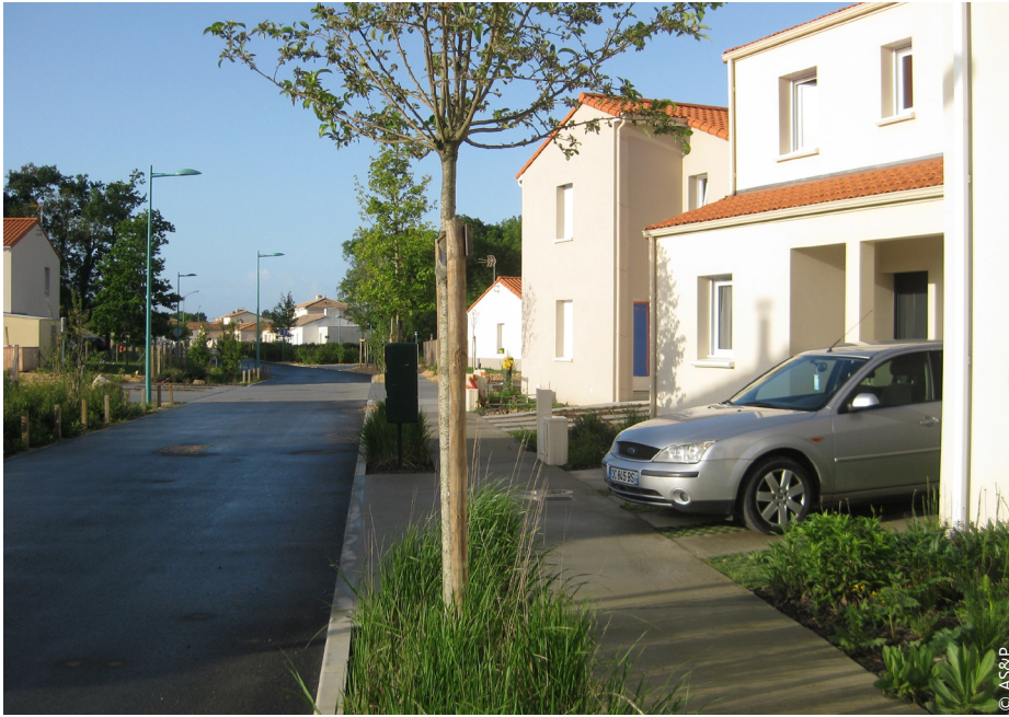
Voie principale avec trottoir et noue Pont-Saint-Martin (44) - Le Haugard 3
