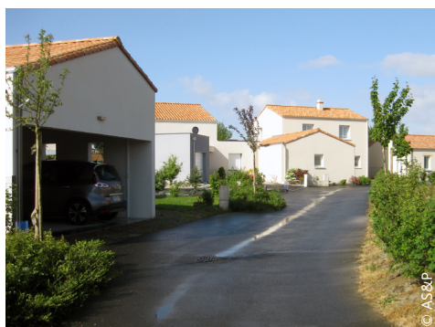
Voie tertiaire Treize-Septiers (85) - La Papinière
