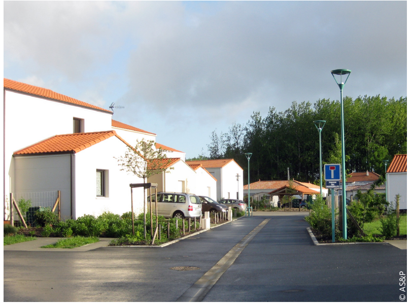
Voie tertiaire en impasse Pont-Saint-Martin (44) - Le Haugard 3
