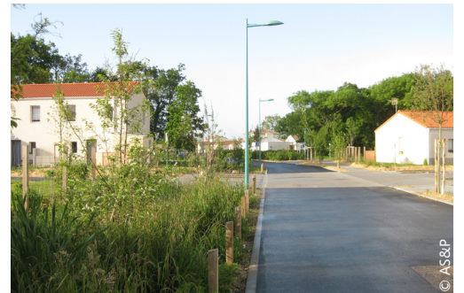
Voie principale avec trottoir et noue Pont-Saint-Martin (44) - Le Haugard 3
