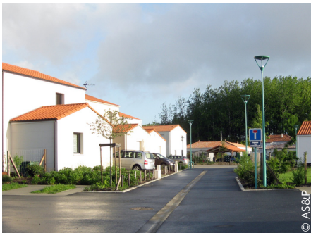
Voie tertiaire - voie partagée Pont-Saint-Martin (44) - Le Haugard 3
