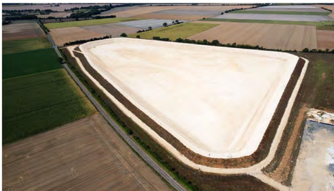
Vue par drone de l'état d'avancement de la retenue SEV15 et de l'aire d'expertise de cette levée de contraintes – Source : Photo drone JF SEROT - Août 2023
