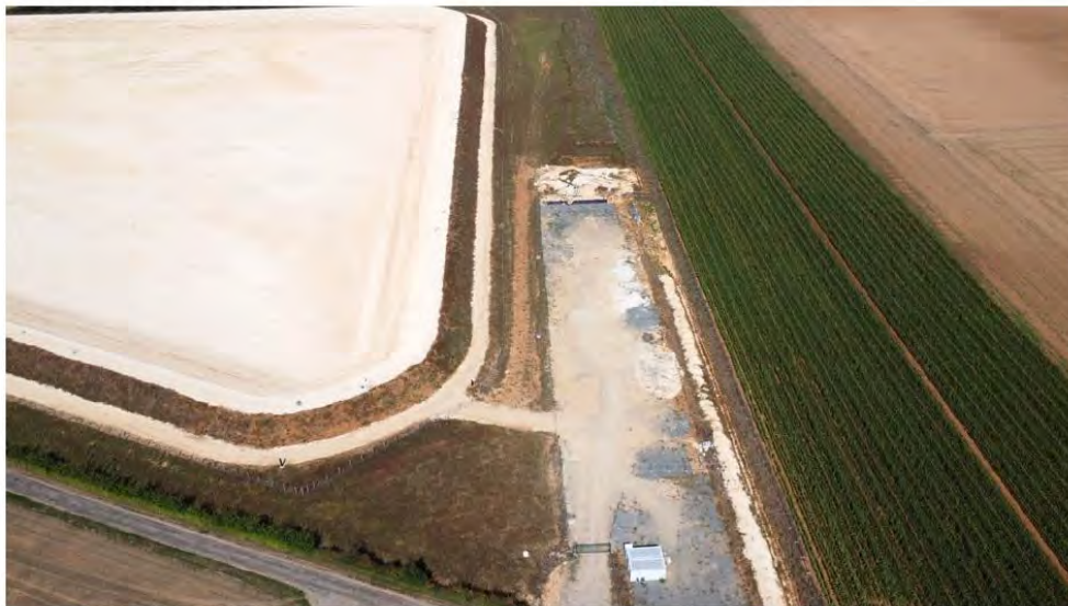
Base vie de chantier et parcelle en maïs limitrophe – Source : Photo drone JF SEROT 2023
