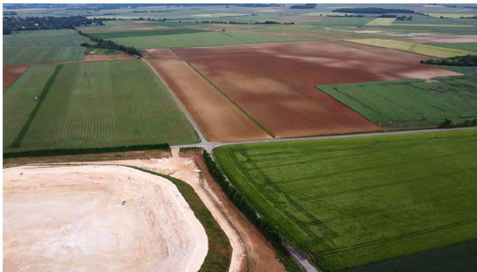
Contexte culturelle élargie du site de la retenue SEV15 – Source : Photo drone JF SEROT 2023
