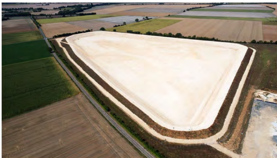
Vue par drone de l'état d'avancement la retenue SEV15 en août 2023 et de l'aire d'expertise de cette levée de contraintes – Source : Photo drone JF SEROT - Août 2023
