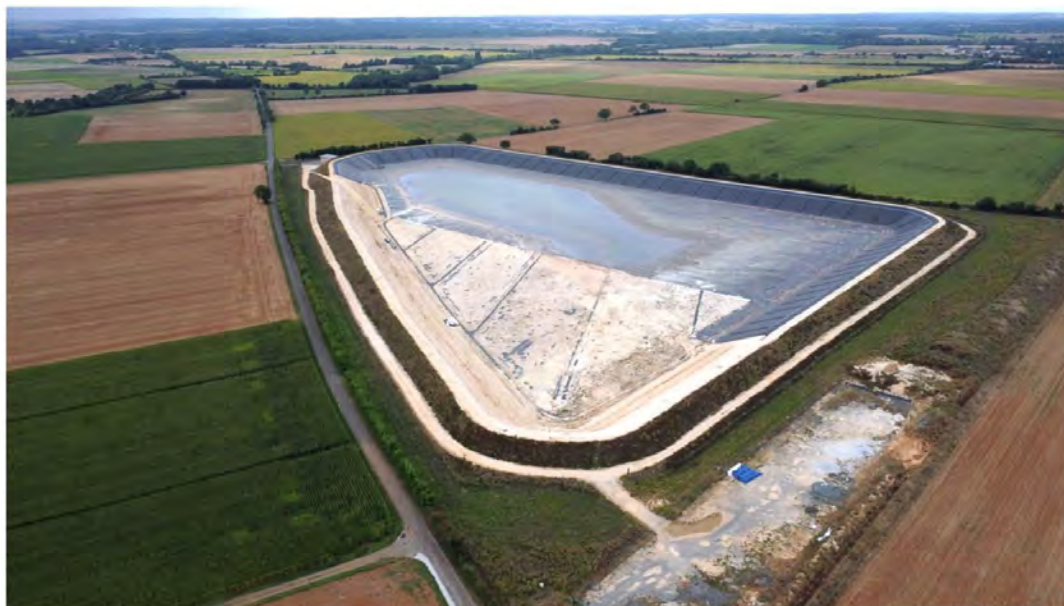
Vue par drone de l'état d'avancement actuel de la retenue SEV15 et de l'aire d'expertise de cette levée de contraintes – Source : Photo drone JF SEROT - Août 2024
