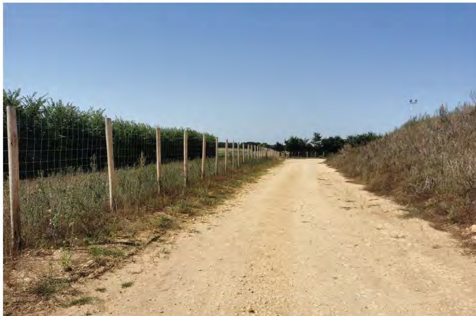
Distance entre la digue de la retenue la haie au Sud du site – Source photo : JF SEROT 2023
