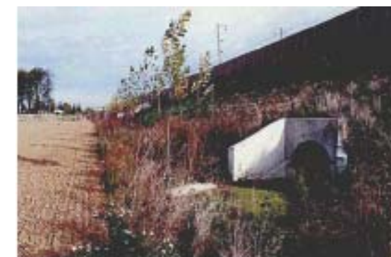
Figure 12 - Ouvrage de traversée hydraulique
