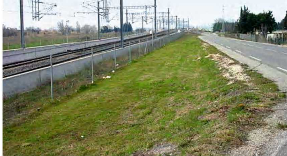
Figure 17 - Exemple de clôture des emprises ferroviaires - (Source : Scetauroute)
