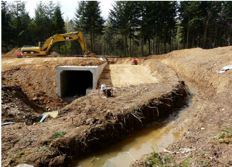
Figure 60 – Exemple de dérivation provisoire permettant de réaliser l'ouvrage définitif à sec (A88)
