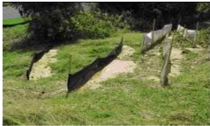
Barrages filtrants en géotextile
