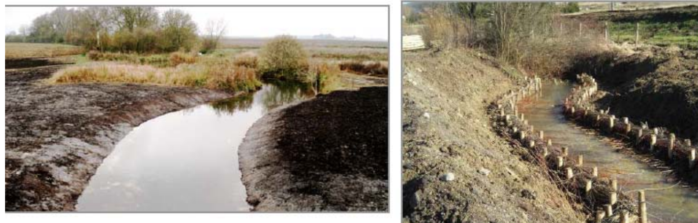
Figure 35 : Exemple de réalisation – Réaménagement écologique de berges
