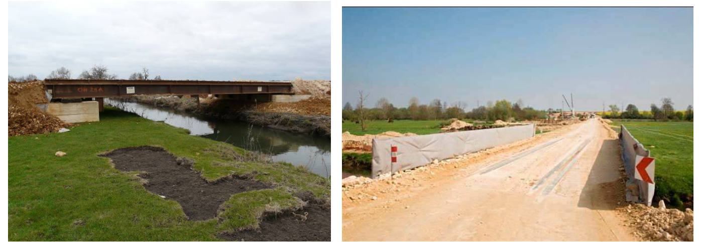
Figure 58 – Exemples de franchissement par pont provisoire (A88)
