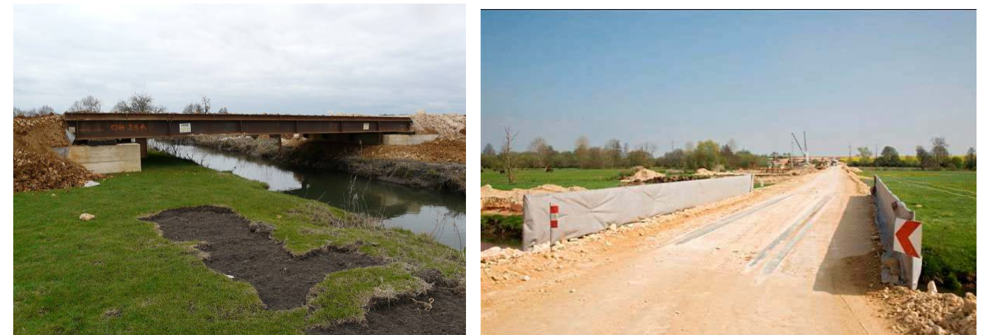
Figure 57 – Exemples de franchissement par pont provisoire (A88)
