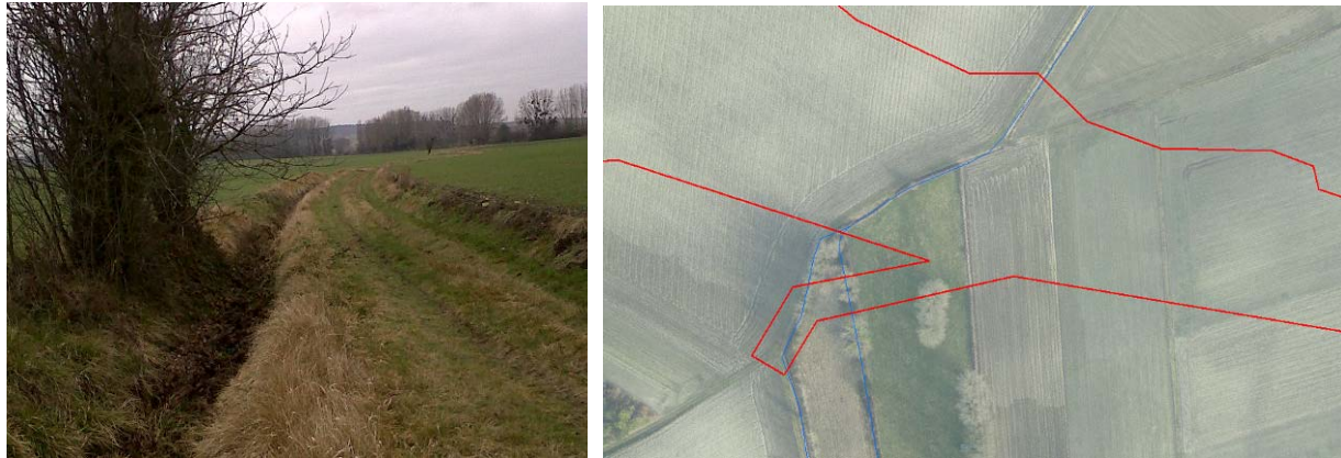
Figure 38 - Cours d'eau les Petits Naintrés au droit du franchissement (photo à gauche, vue aérienne à droite)
