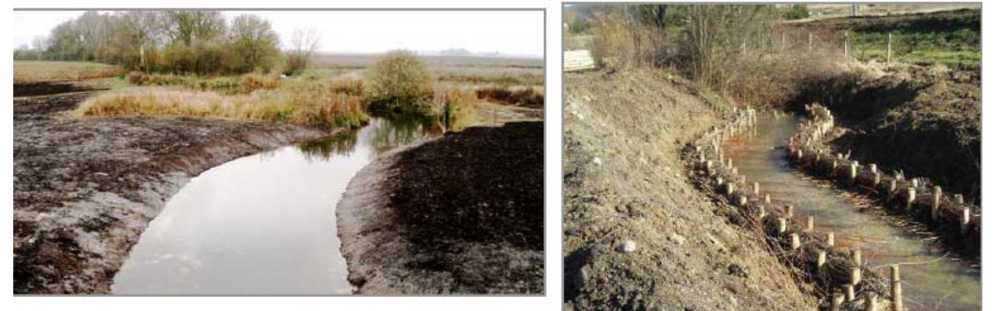
Figure 35 : Exemple de réalisation – Réaménagement écologique de berges
