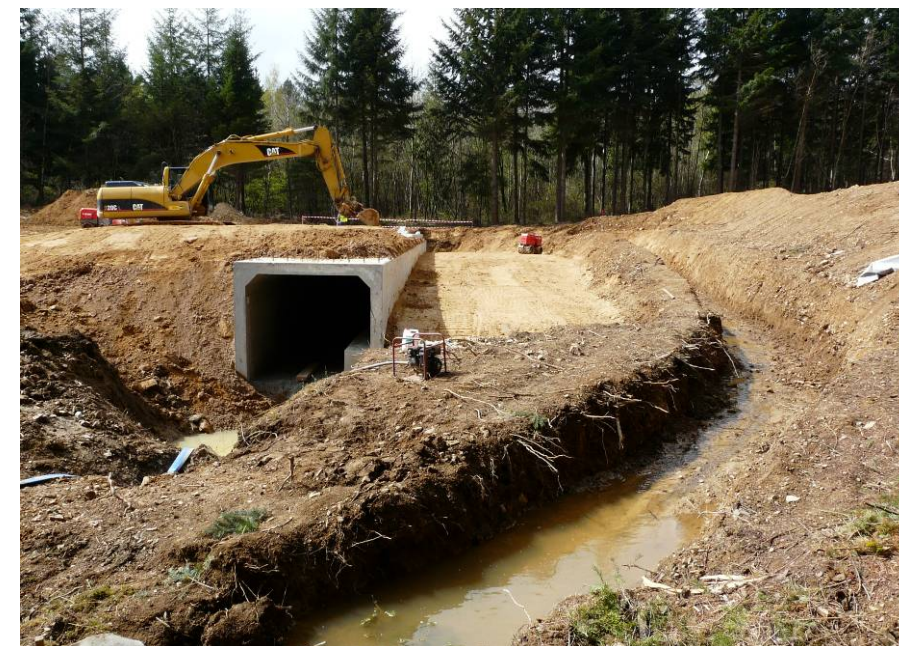
Figure 59 – Exemple de dérivation provisoire permettant de réaliser l'ouvrage définitif à sec (A88)
