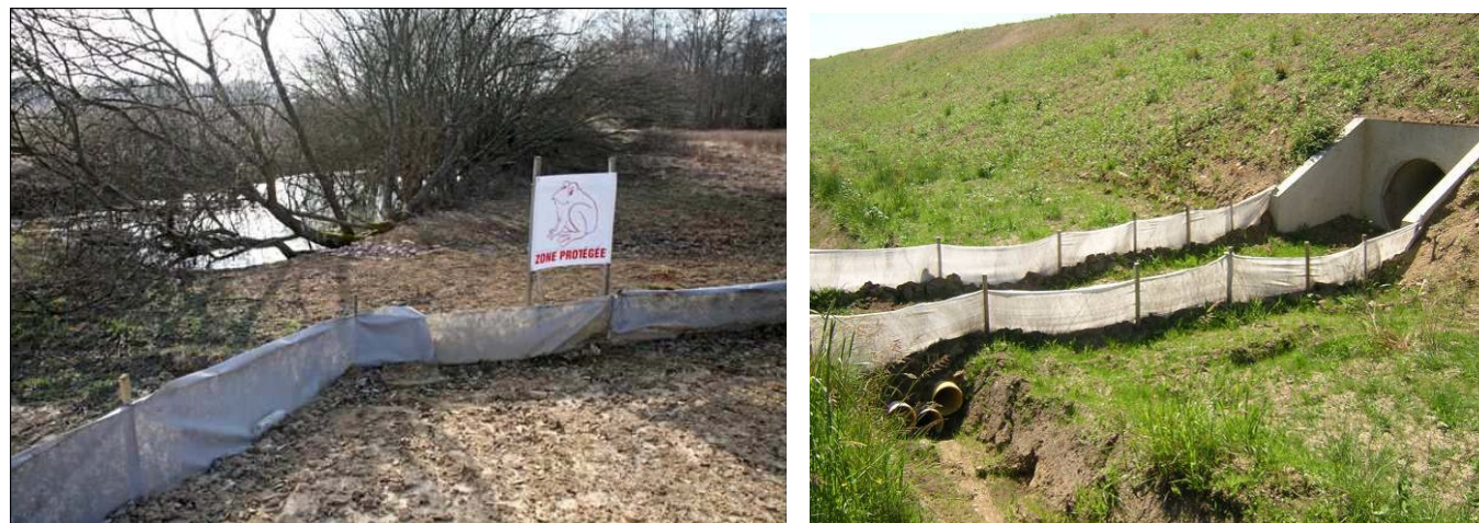
Figure 62 – Exemples de clôtures provisoires anti-intrusion pour les amphibiens @ Egis
