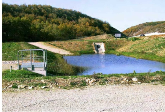
Figure 13 - Exemple de bassin de traitement
