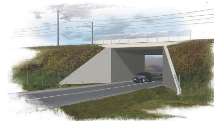
Figure 24 - Pont-rail de type cadre ou portique (Source : SNCF/ARCADIS - Dossier de consultation, 2006)
