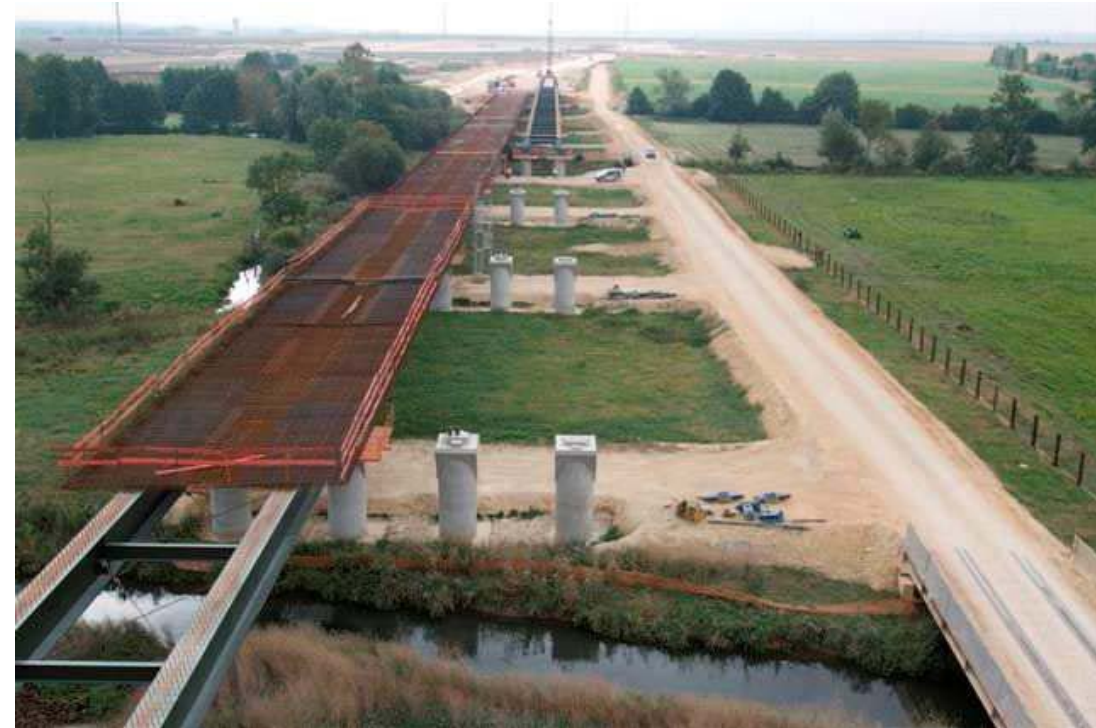
Figure 54 – Illustration de piste pour construction d'un ouvrage d'art (vallée de l'Orne, A88)
