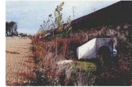
Figure 12 - Ouvrage de traversée hydraulique
