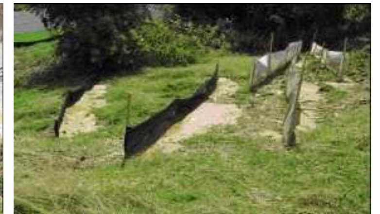
Barrages filtrants en géotextile
