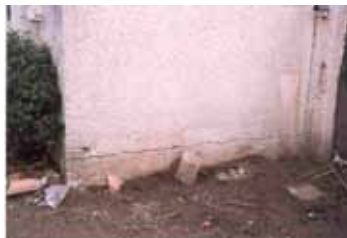
Fissuration horizontale
