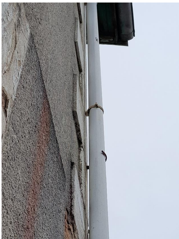
Photo 16: Gouttière façade Nord
