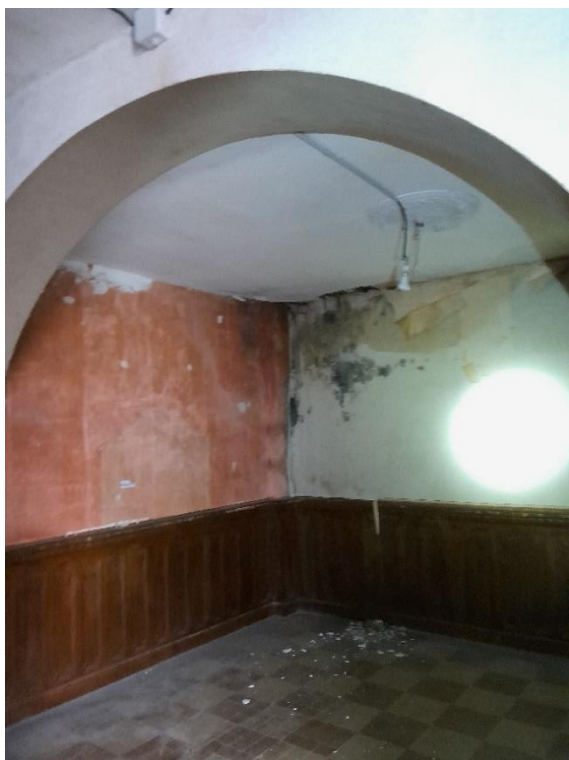
Photo 21: Intérieur du bâtiment
