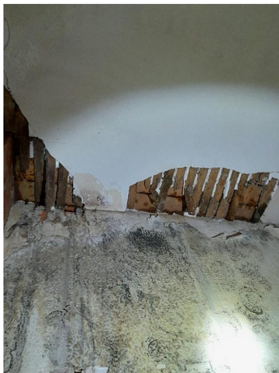
Photo 22: Plancher haut RDC
