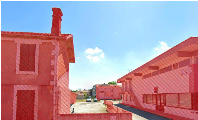
Figure 1 - Bâtiments à démolir
