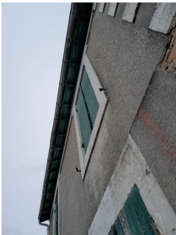
Photo 3: Débord toiture face Nord
