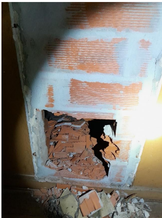
Photo 32: Accès comble dépendance
