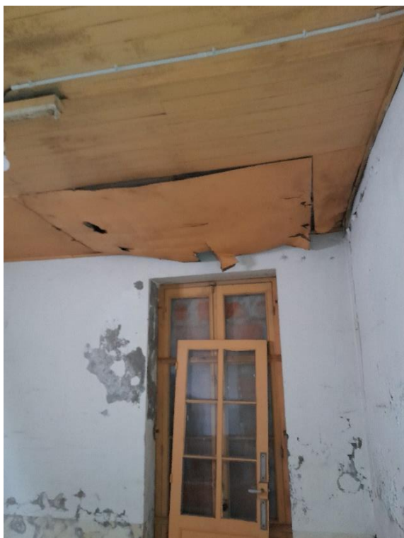
Photo 25: Pièce n°2 - Plancher haut RDC
