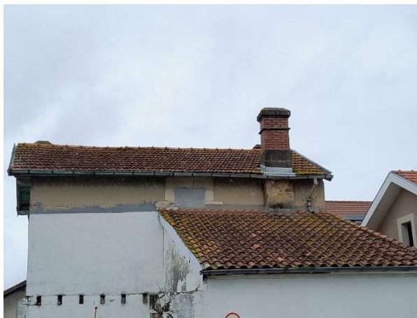
Photo 14: Toiture façade Sud
