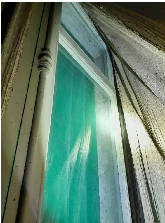
Photo 30: Intérieur des volets
