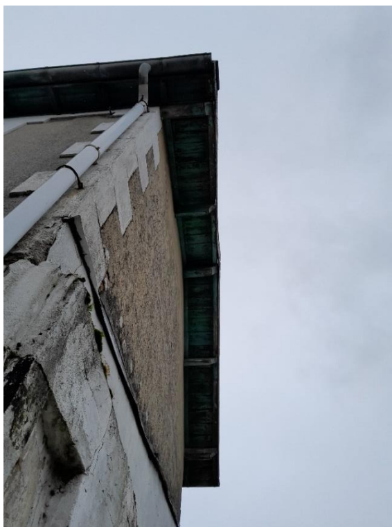
Photo 4: Debord toiture face Ouest
