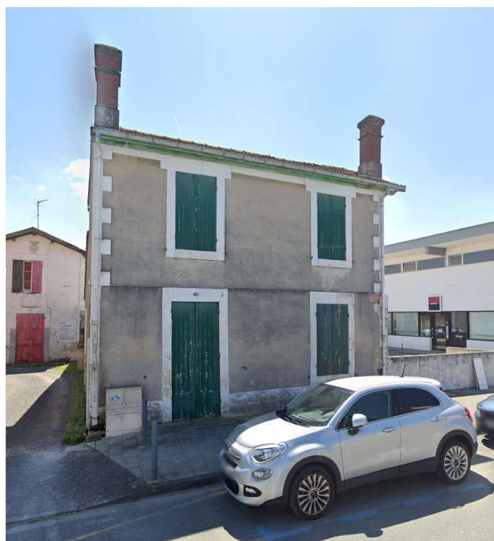
Figure 4 - Vue bâtiment depuis le Cours de la République
