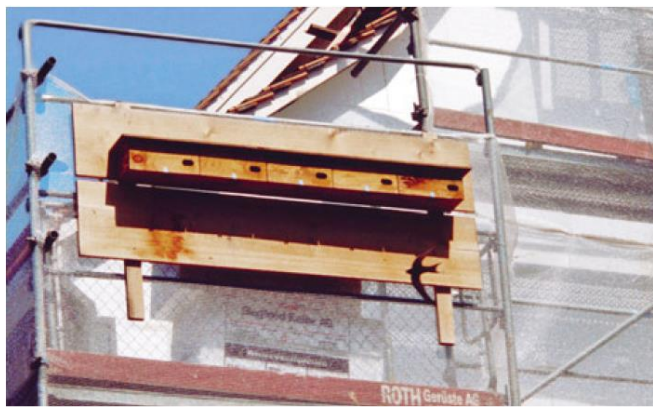
Photo 42 : Exemple d'installation temporaire de nichoirs à Martinet noir sur un échafaudage (Source Scholl)
