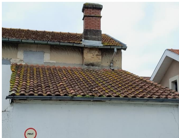
Photo 15: Dépendance façade Sud - zoom
