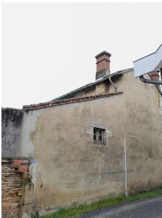
Photo 2: Façade Est côté impasse
