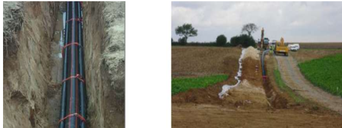
Figure 5 : Exemple de pose en milieu agricole
