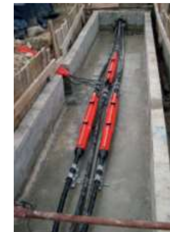
Figure 6 : Exemple de chambre de jonction
