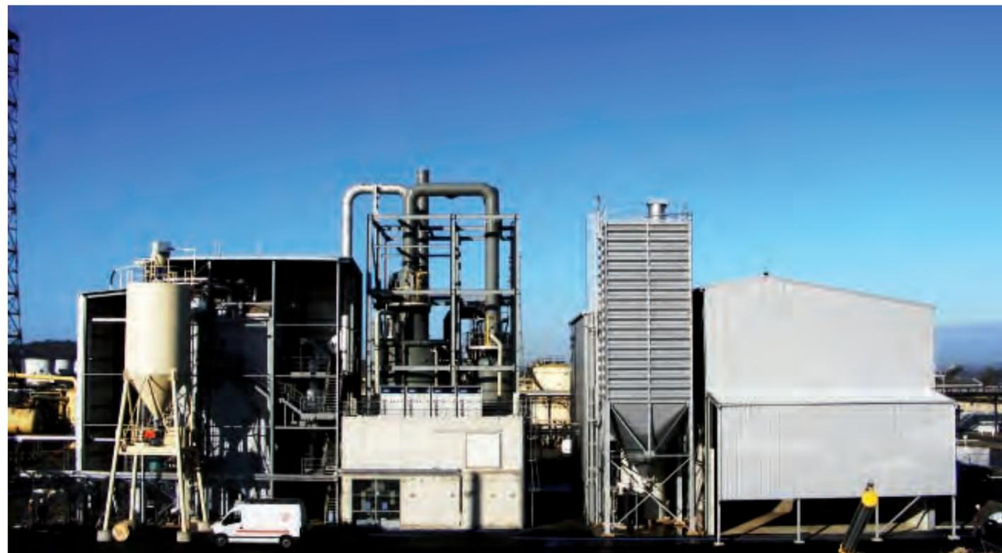
consomme le calcaire approvisionné localement par la société Carmeuse (1 tonne de calcaire permet de produire 1,72 tonne de gypse). Ce gypse, qui présente un taux de pureté très élevé (plus de 95 %) se substitue partiellement à une ressource naturelle et peut, au même titre que le plâtre de déconstruction, faire l'objet d'une réutilisation quasiment infinie dans les filières développées par les industriels du plâtre.
