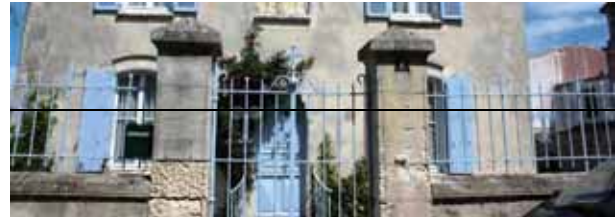
exemple de clôture urbaine avec grille sur mur-bahut
