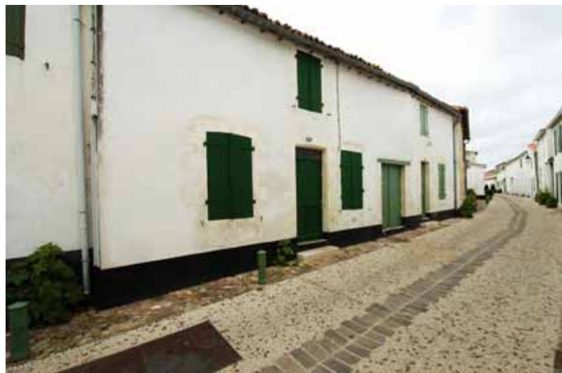
Façade aveugle En partie (ancien grenier)
