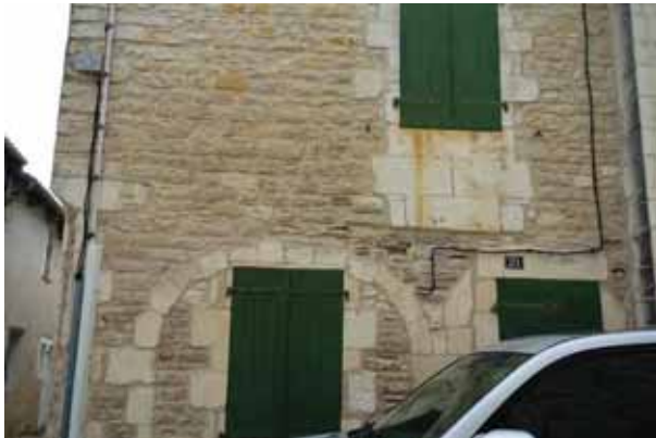
D'anciennes échoppes ou ouvroirs sont appropriées aux devantures commerciales en dégagant le remplissage au profit d'une grande baie.
