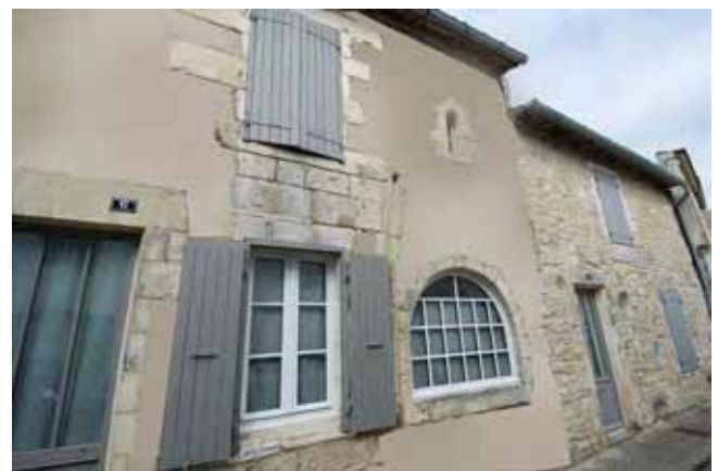
APRES : mise en valeur de la pierre de taille noble et des encadrements, la petite pierre doit être enduite : OUI
