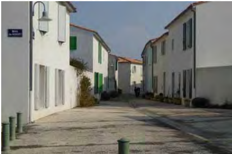
Des constructions récentes, en général, qui peuvent être démolies et remplacer dans les même caractéristiques que l'existant pour préserver la composition urbaine.
