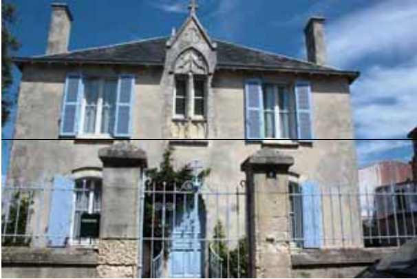
Clôture du presbytère – Ph M.Berthomès 17-11-2013
