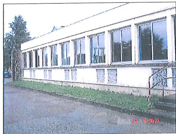
Photo 4. Bâtiment situé au dessus de l'extrémité Sud du niveau -20
