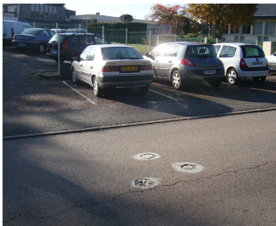
Traces des sondages au niveau de la route départementale
