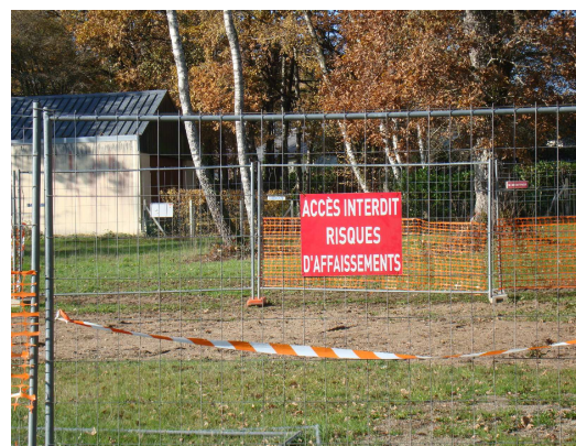
Mise en sécurité provisoire
