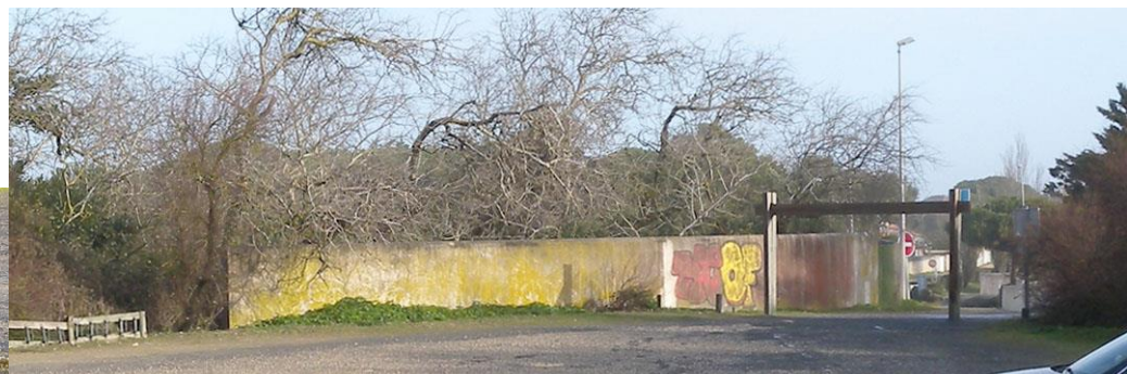
Un mur peu valorisant accueille les vacanciers à l'entrée du site
