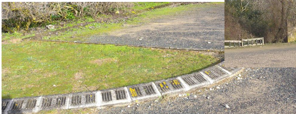
Délimitation des bandes végétales par des bordures en béton sur la majorité du parking
