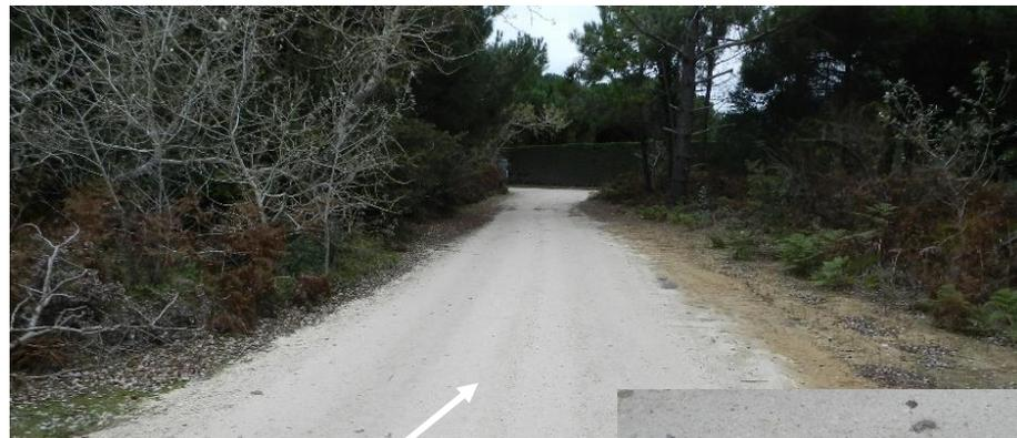
Revêtement stabilisé calcaire de couleur claire pour **les bandes de roulement** (ex : Le Bois Plage en Ré)
