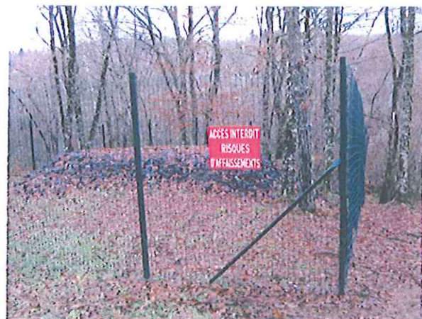
Site de La Clare : comblement / recharge tête du puits P1 – Périmètre de sécurité
