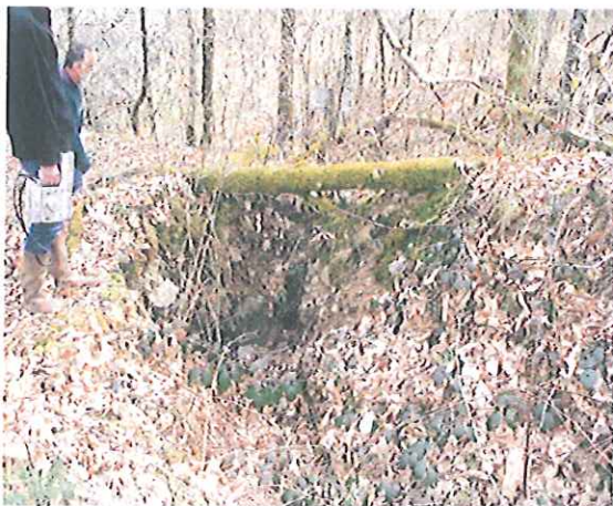
Site de La Clare : comblement / recharge tête du puits P1 – Périmètre de sécurité
