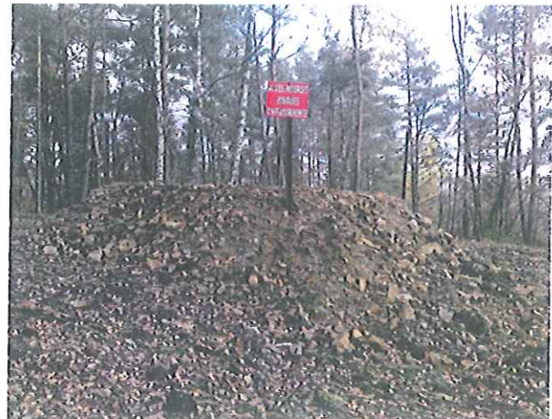
Site du Peuch : recharge de la tête de puits
