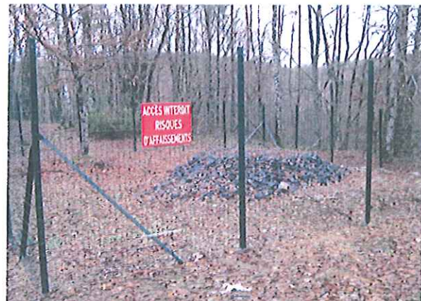
Site de La Clare : comblement / recharge tête du puits P2 – Périmètre de sécurité
