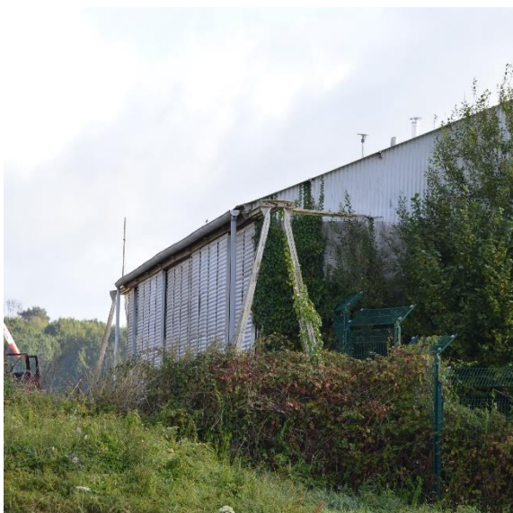
Photo 18 : locaux de l'école de vol à voile – AE, septembre 2024
