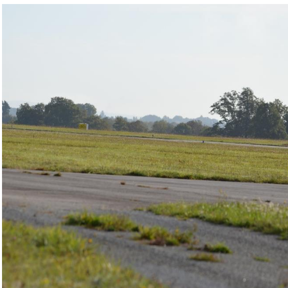
Photo 20 : zone de servitude – AE, septembre 2024
