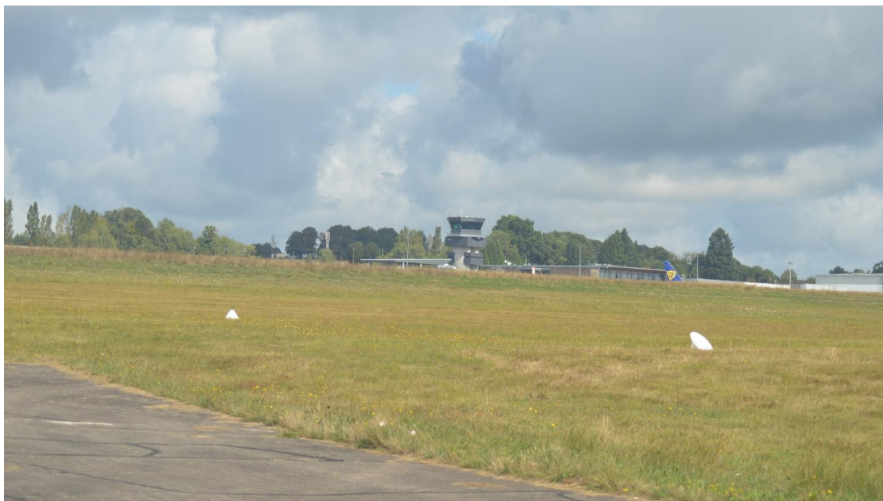
Photo 2 : Vue de la Tour de contrôle depuis la plateforme -AE, septembre 2024
