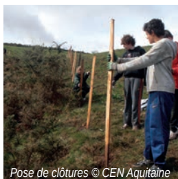
Pose de clôtures © CEN Aquitaine
