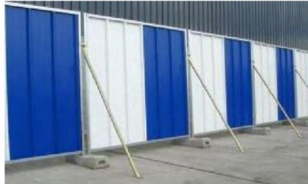
Photo 12 : Exemple de dispositif de délimitation de la zone chantier
