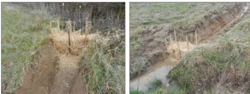
Bottes de paille filtrantes en phase chantier
