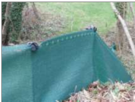
Filet de protection temporaire et retournement aux extrémités à respecter
