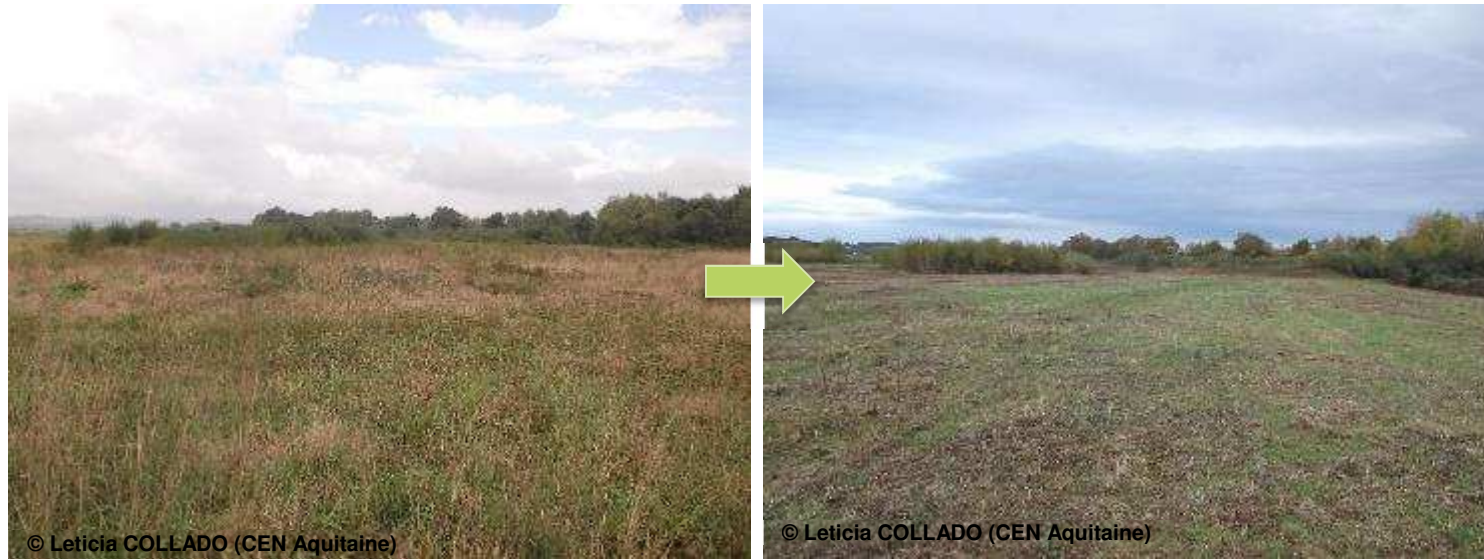
Broyage d'entretien de la végétation – Carrière de Lescar – photos avant (à gauche) et après travaux (à droite)
