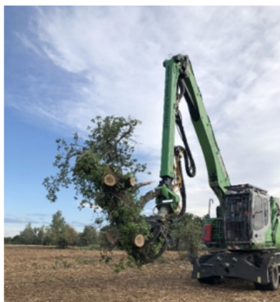
Figure 54 : Manipulation d'un tronçon d'arbre gîte potentiel afin de limiter les impacts sur les Chiroptères arboricoles Source : Egis
