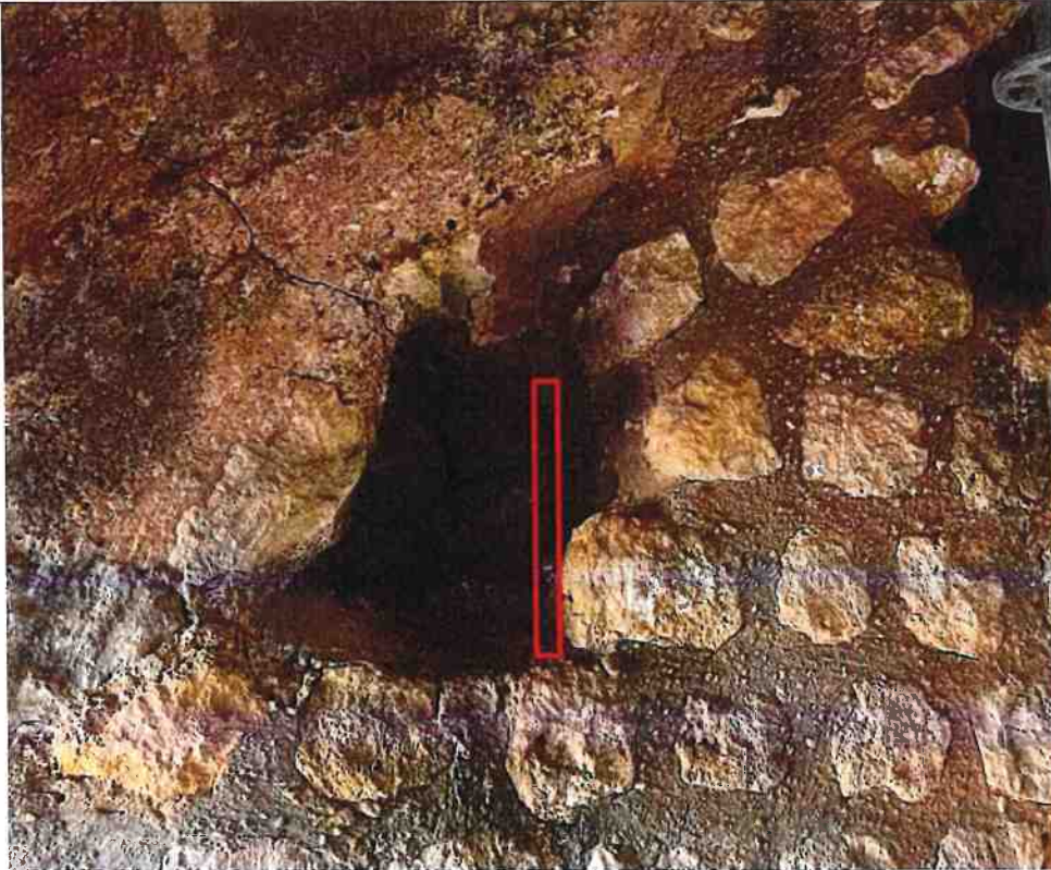
Figure 21 Localisation du positionnement d'une faille à créer à l'entrée d'un trou de boulin
