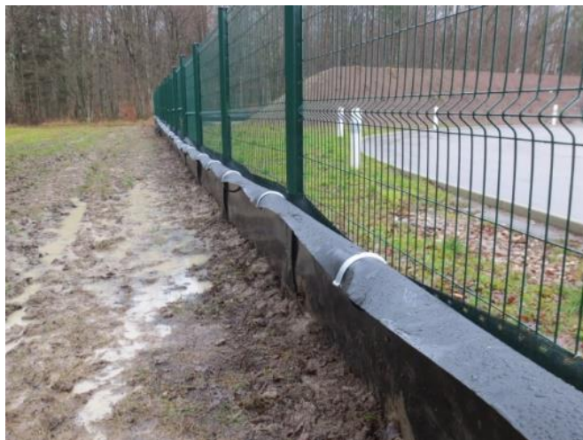
Figure 32 : Exemple de membrane installée avec système anti-retour (photos Écosphère)
