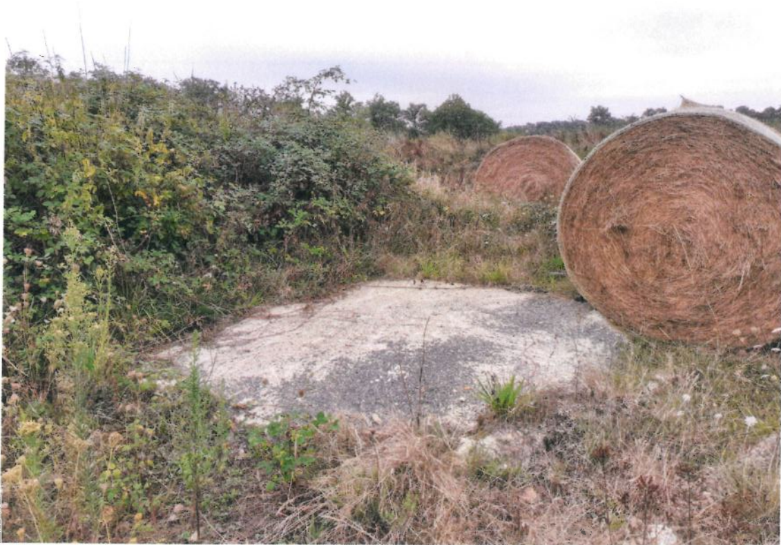
Figure 5 : Localisation de la dalle béton recouvrant le puits (travers-banc-135)
