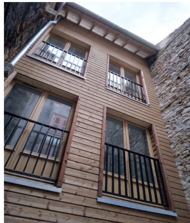
Puits de jour après curetage
