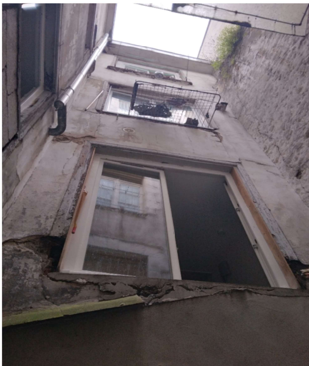
Puits de jour avant curetage
