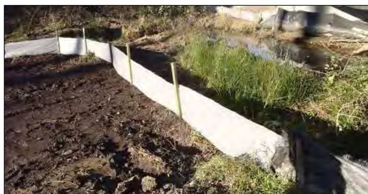
Implantation de barrières amphibiens en géotextile permettant d'éviter les déplacements des individus des fossés vers le chantier © ETEN Environnement
