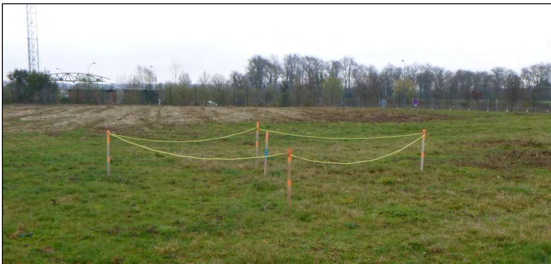
Exemple de mise en défens par balisage à l'aide de corde fluo et de piquets © ETEN Environnement
