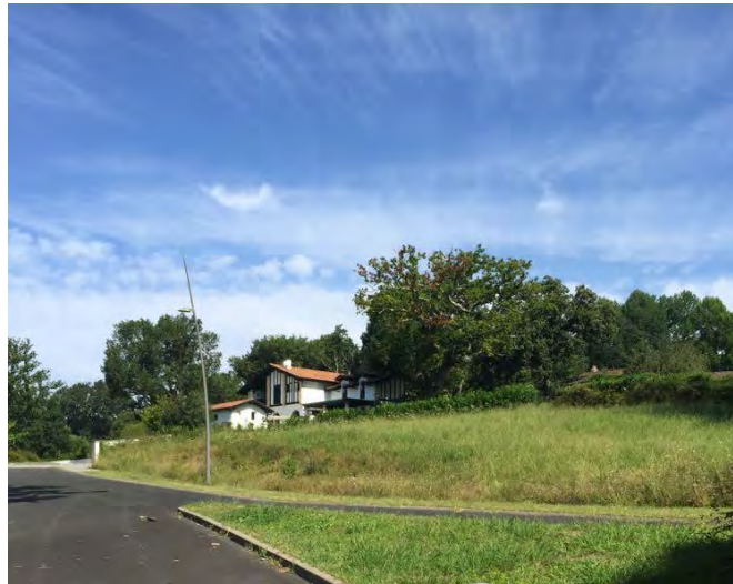
Habitation existante conservée ©ETEN Environnement
