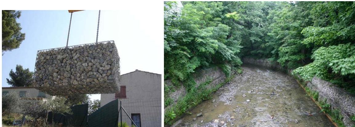
Figure 28. exemples de confortement de mur par gabions boîtes
