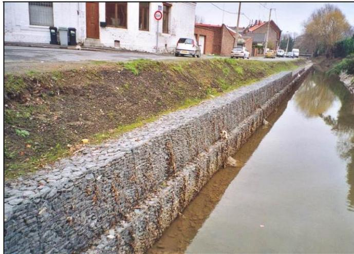
Figure 35. exemple de mur en gabion avec talus arrière (source : Maccaferri)
