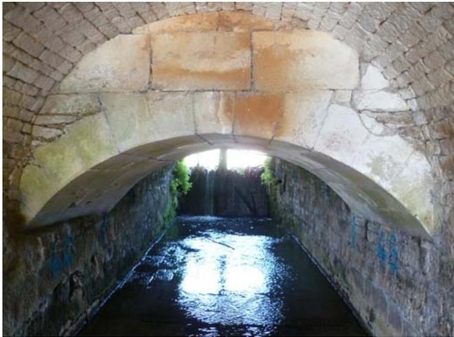
Photo 5 : vue aval du canal 1 avec vannes amont et petite voûte
