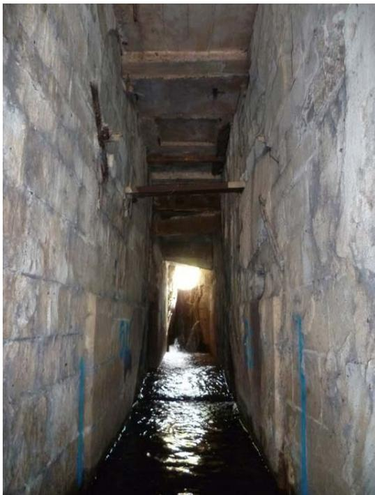
Photo 6 : vue aval du canal 2 avec batardeau amont
