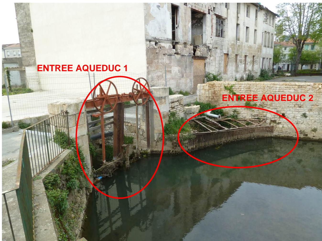
Figure 10. Deux prises d'eau vues à partir du bassin amont
