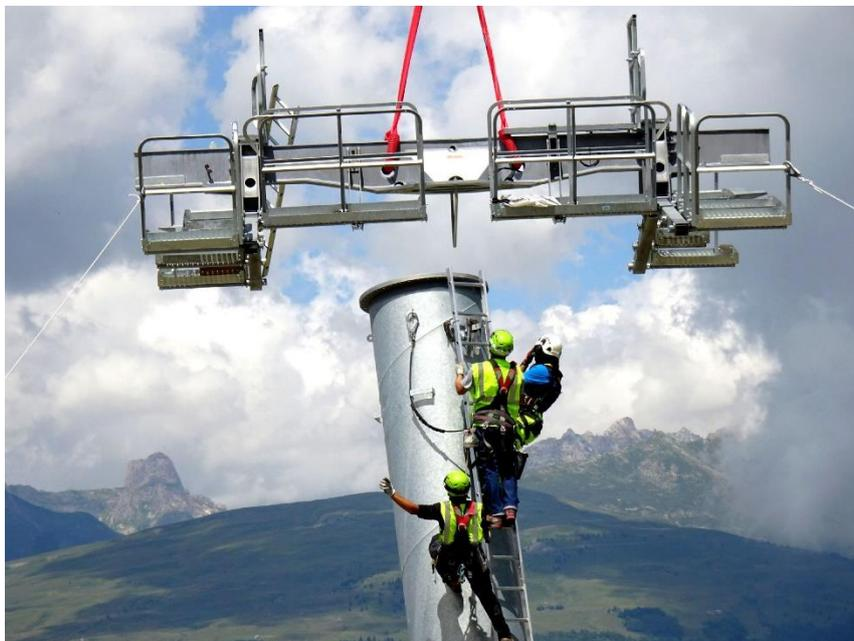
Photo 2 Exemple d'installation de pylône obturé au sommet
