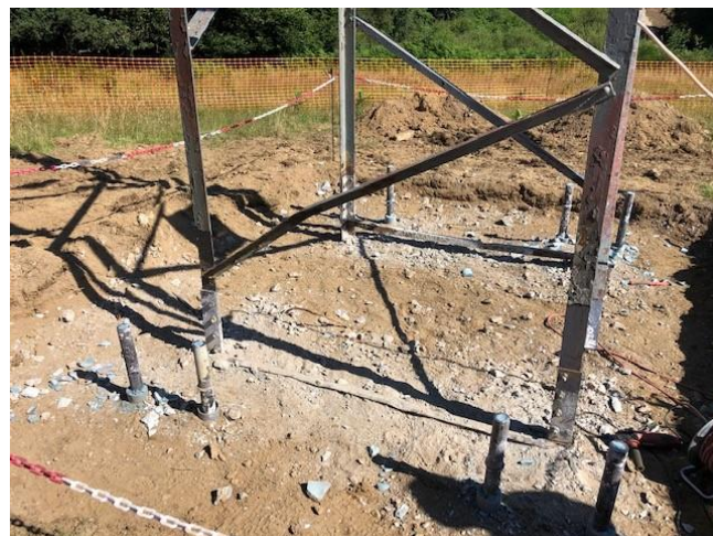
Figure 18 : Pylône renforcé par pieux
