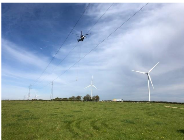
Figure 22 : Déroulage de câbles par technique héliportée
