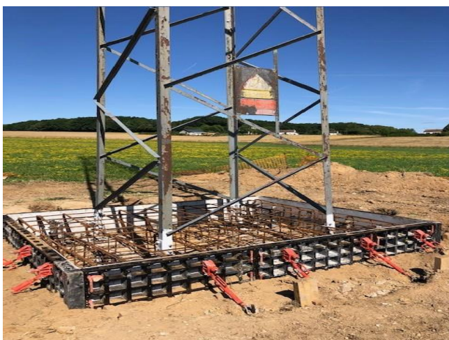
Figure 20 : Ferrailage fondation
