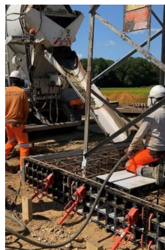
Figure 19 : Bétonnage fondation
