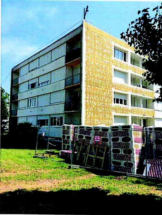
Figure 8 : travaux d'isolation sur la résidence Curegan, Blanquefort ©LPO Aquitaine
