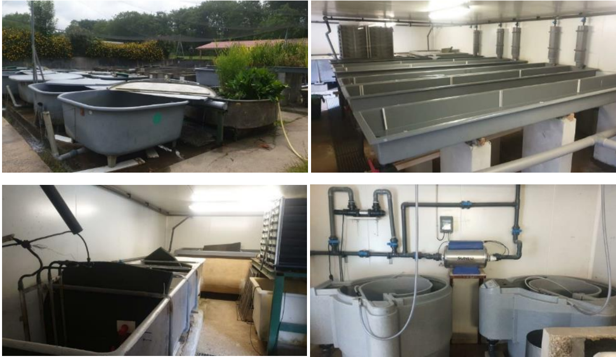
Figure 8 : Pisciculture du Lycée Agricole de Saint-Pée – De Gauche à droite et haut en bas : Bassins extérieurs utilisés pour la salmoniculture, installations de l'écloserie, bassin tampon et système de filtration (photos C. Nannini)
