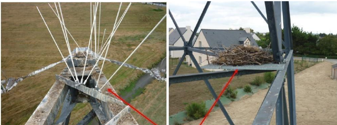
Figures 18 & 19 : Pose de pics PFISTERER et caillebotis pour l'accueil de nid (RTE)
