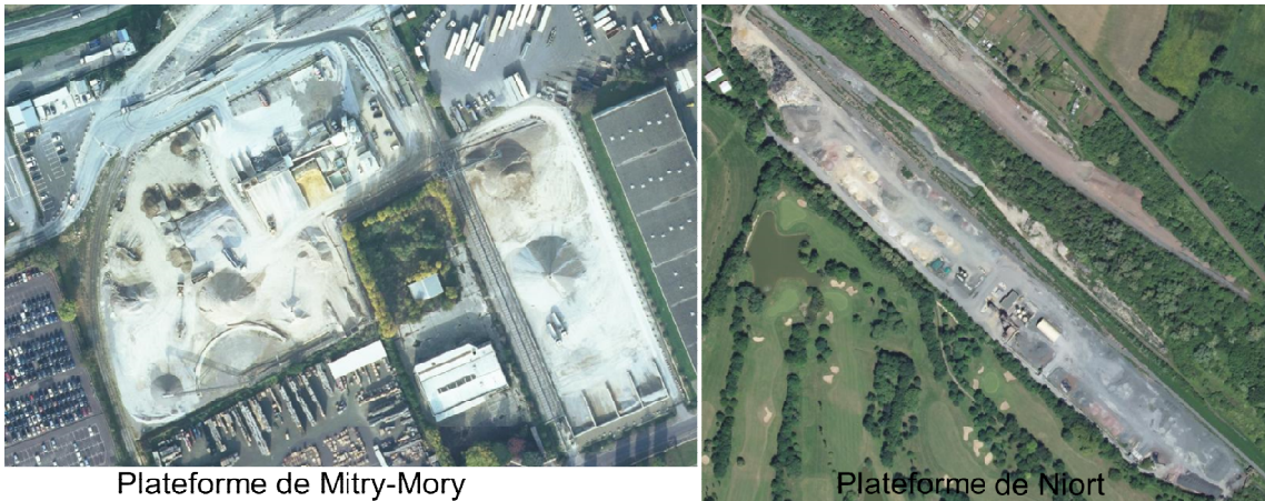
Figure 6 : exemples d'aménagement des zones de stockage de deux plateformes embranchées
