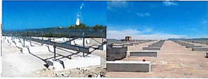
Modèles de longrines-bétons (extrait de l'étude d'impact page 21)
