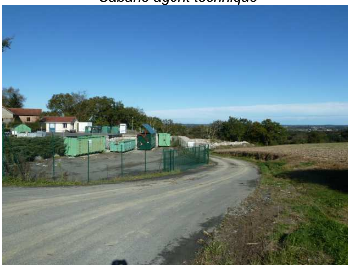
Depuis le CR d'accès à la déchetterie existante
