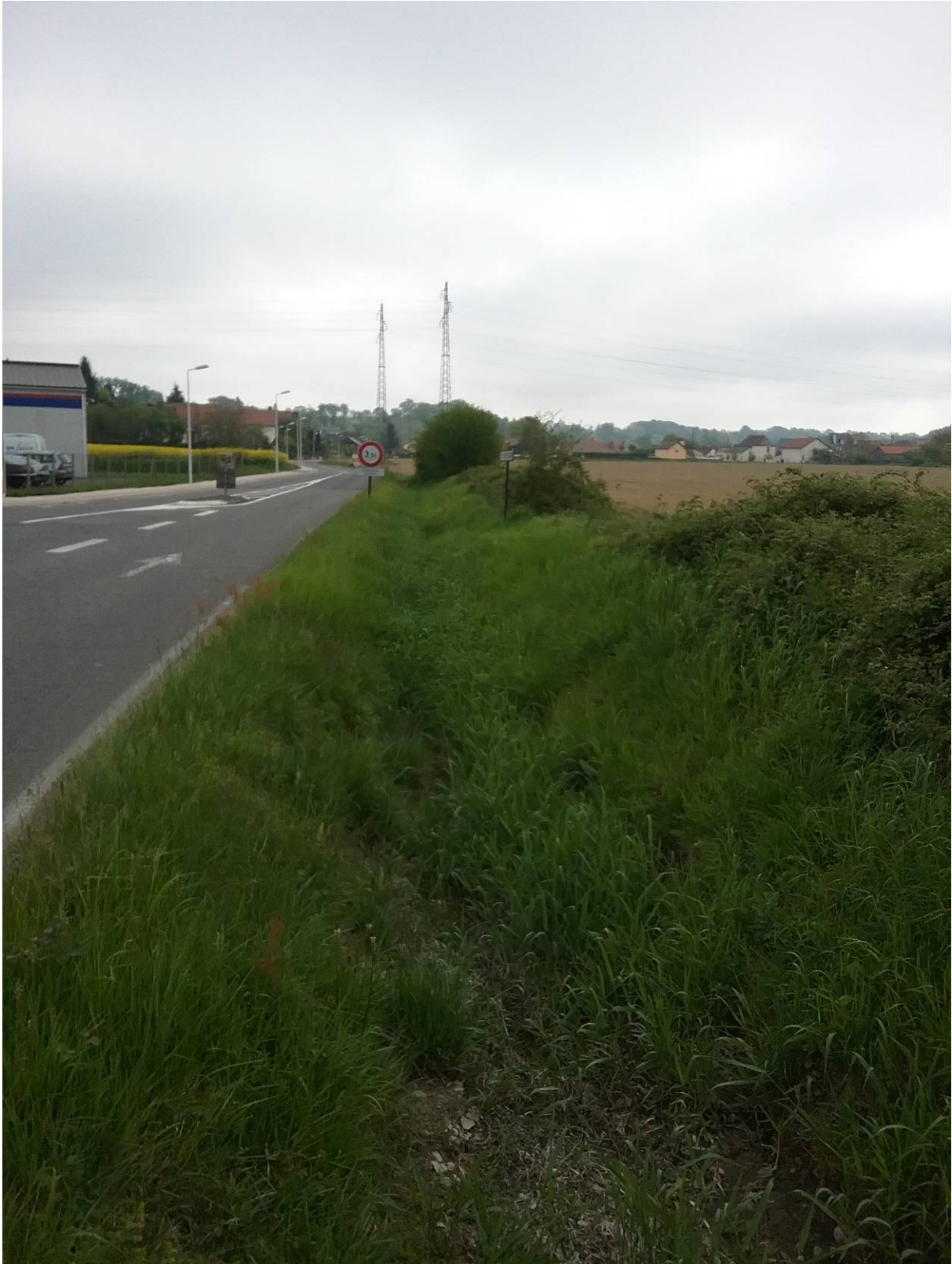
Figure 5: vue de l'entrée de ville sur le CD208
