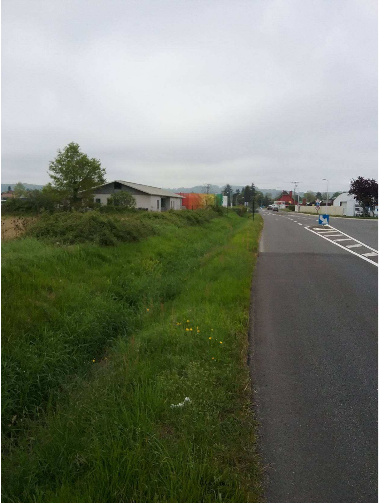
Figure 4: vue des installation intercommunales depuis le CD208
