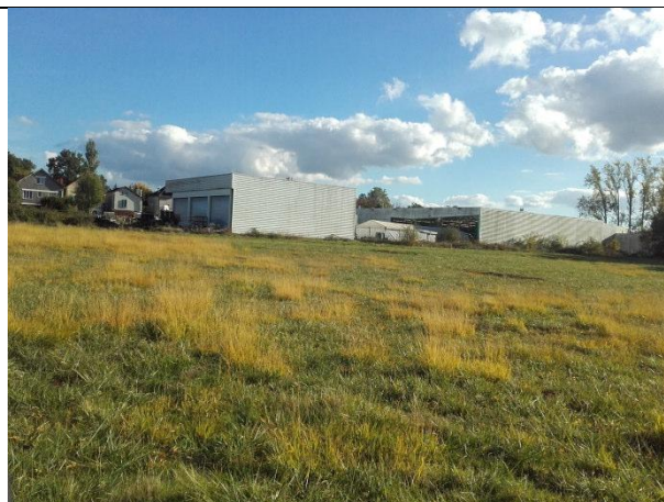
9 : Vue en direction de l'est et du sud-est : entrepôt du site et Mr. Bricolage (10/2016)
