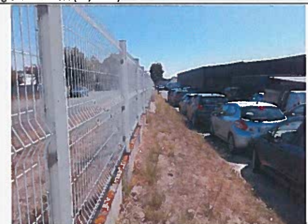
3 : Vue de la limite nord du site (08/2016)
