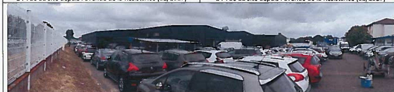
3 : Vue du site depuis l'angle nord-ouest (07/2016)
