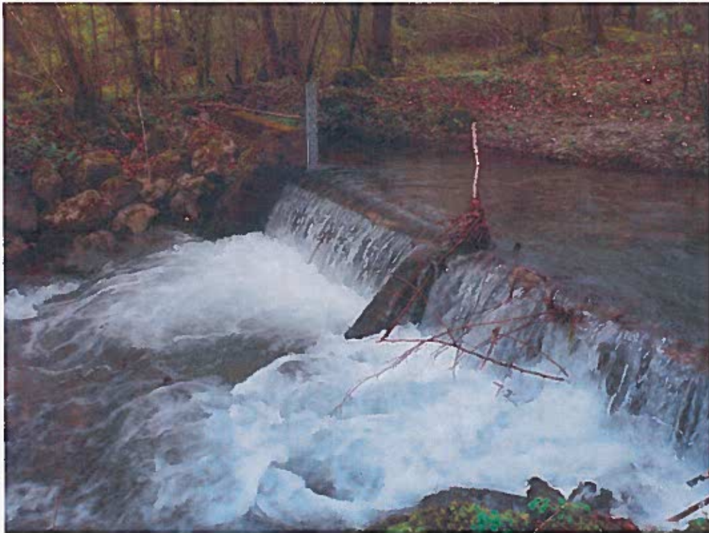
Barrage vue aval (mars 2017)
