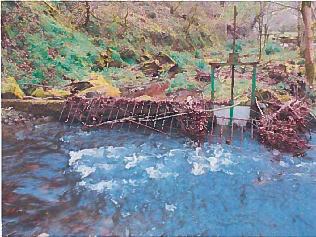
Barrage rive gauche vue amont et vanne d'entrée de buse (mars 2017)
