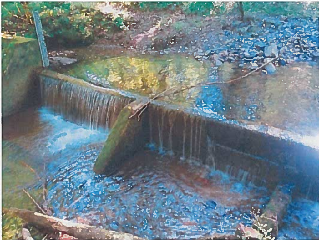
Barrage vue aval
