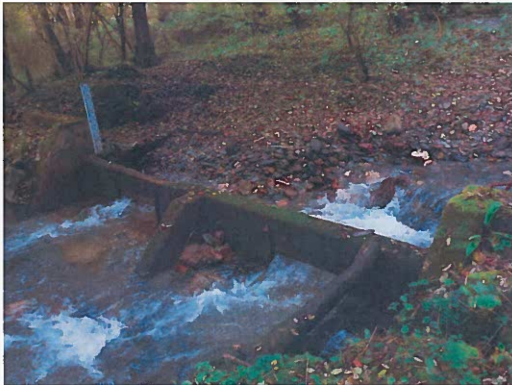
Barrage vue aval (octobre 2016)
