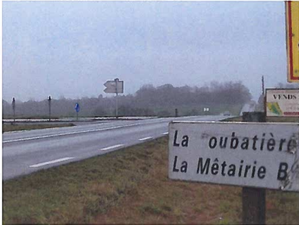
Photographie 4 – intersection RD948 / RD 45 (vue vers l'est. Source : Egis, décembre 2014)
