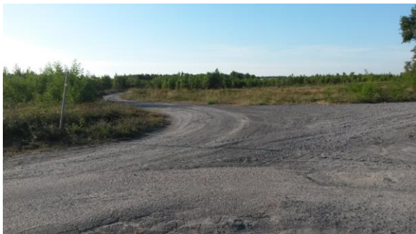
Photographie 5 : Vue du chemin d'accès à la déchetterie communale et à la parcelle
