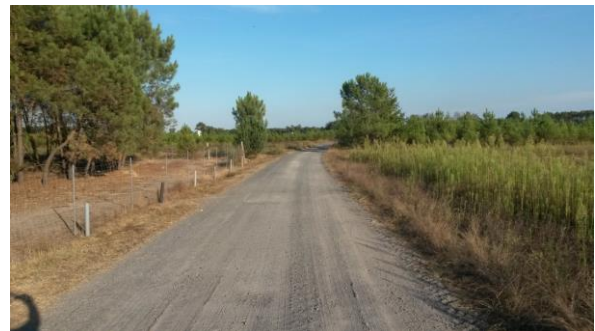
Photographie 6 : Vue du chemin d'accès depuis l'Ouest
