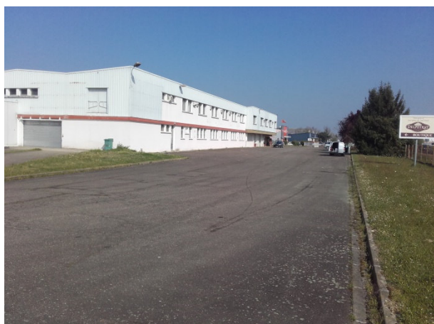
6 : Vue en direction du nord de la limite est du site (04/2017)
