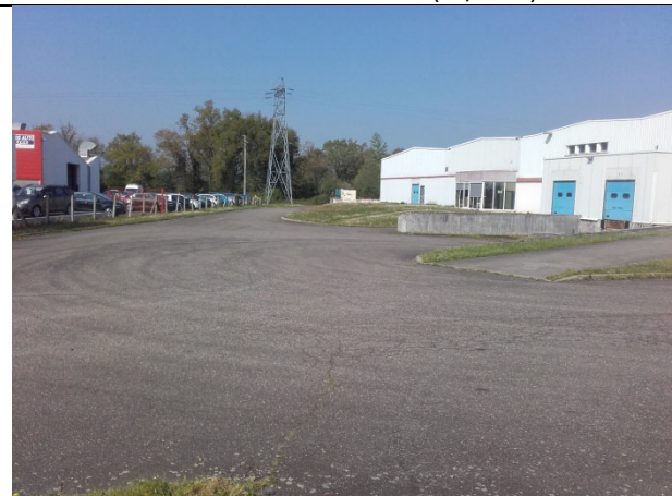
5 : Vue en direction de l'ouest de la limite sud du site (08/2016)
