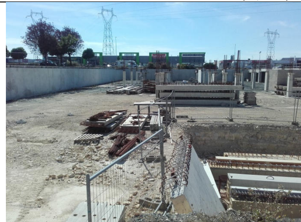
6 : Vue du site en direction du sud (09/2016)
