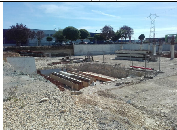
5 : Vue du site depuis le nord en direction du sud-est (09/2016)
