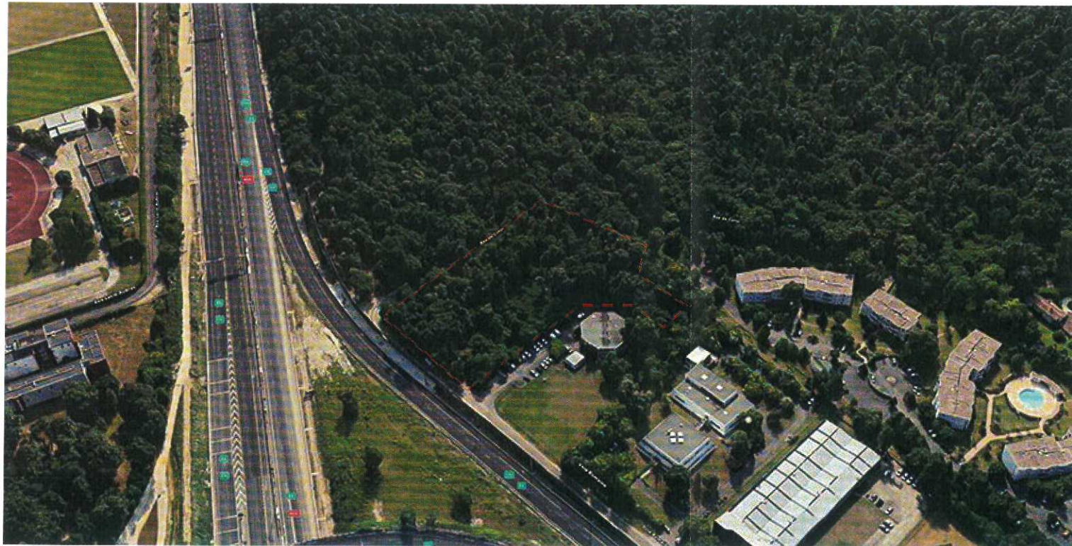
Vue lointaine - PC8
